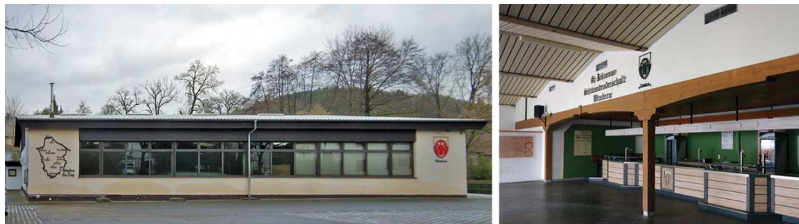
Abbildung 40: Schützenhaus Wimbern, Außenansicht, Innenraum Thekenbereich
