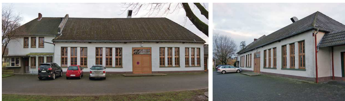
Abbildung 39: Gemeindehalle Echthausen, Außenansicht
